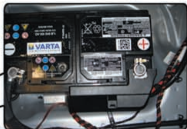
главный блок предохранителей
